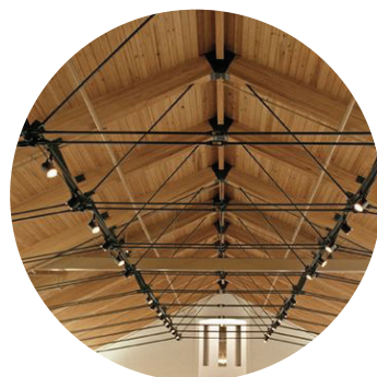
Dřevo + ocel viditelná konstrukce krovu nad sálem
